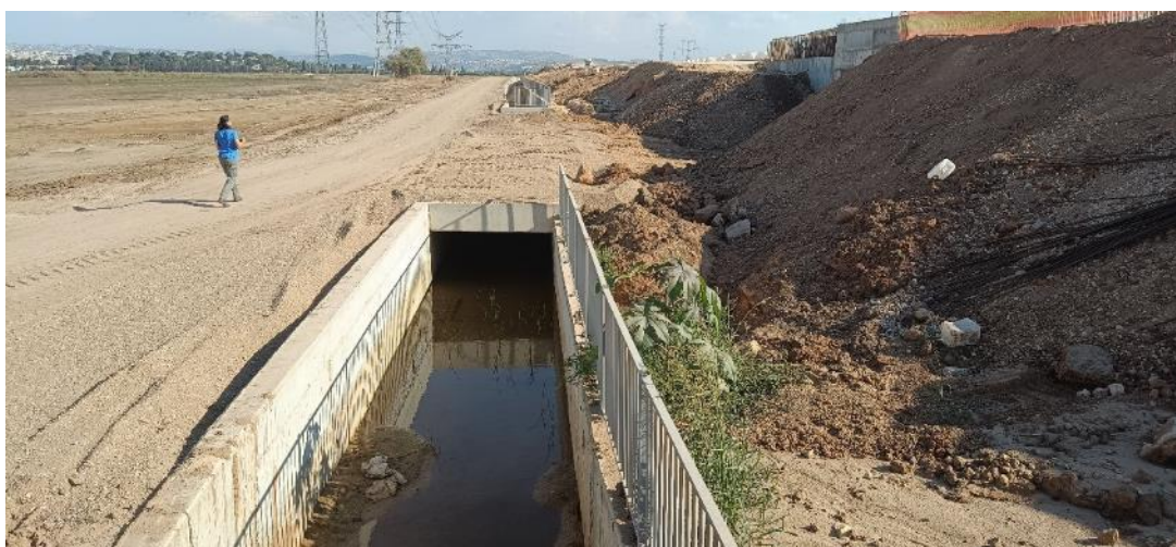
תמונה 7 מעלה הנחל זורם בתעלת ניקוז מבוטנת כחלק ממערך המסילה המזרחית
