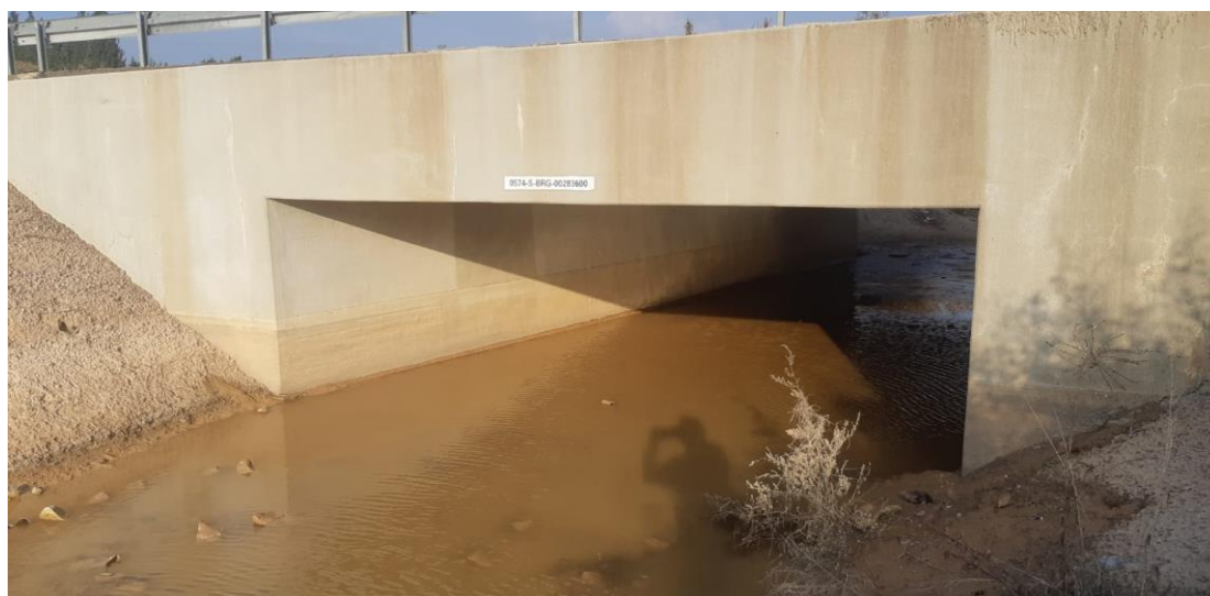
איור 5 - מעביר כביש 754
