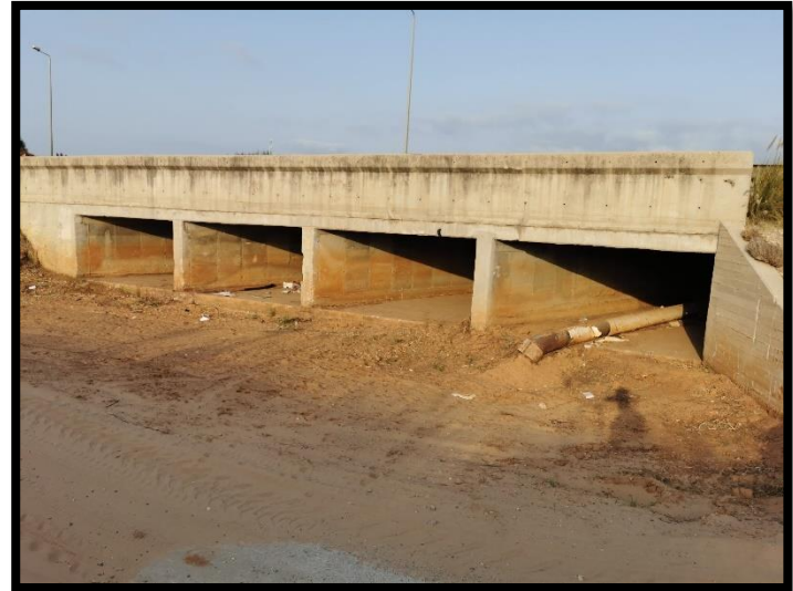
תמונה 1 ב' - מתקן מספר 1, מעביר מים מתחת לכביש מספר 4 תמונה 1 א' -מתקן מספר 9, מעביר מים מתחת לכביש מספר 4
