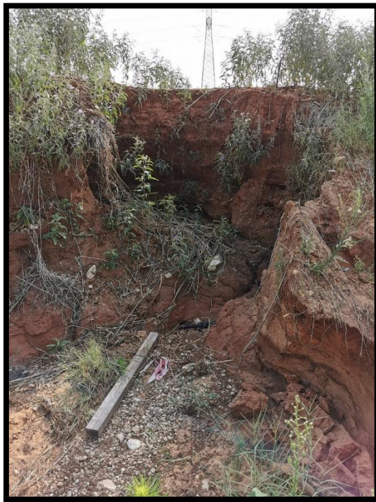
תמונות 6 א'-ב' - ארוזיה פנימית – Piping, בגדת הנחל
