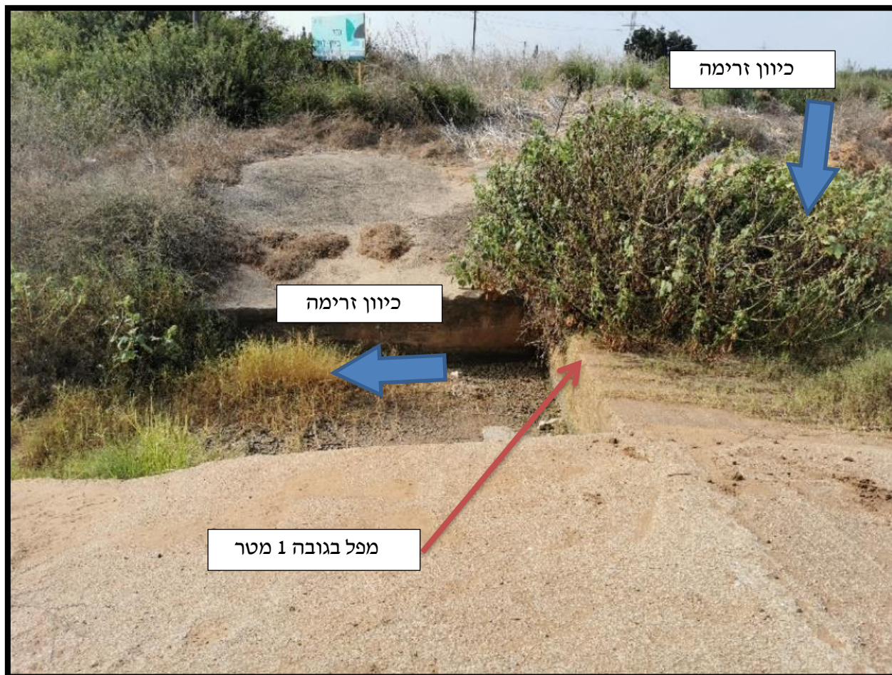
תמונה 5 - מתקן מספר 2, מפל במעלה מתקן מספר 1, מתחת למפל יש קו תקשורת
