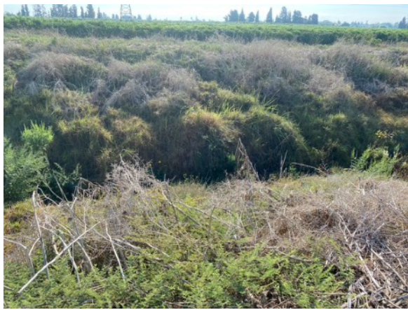
מבט מהגדה המערבית לכיוון מזרח. עומק הנחל כאן כ-3.5 מ. גדות תלולות ולא עבירות. סבך גדות בהובלת אמברוסיה מכונפת וחילף החולות. (חתך 45).
