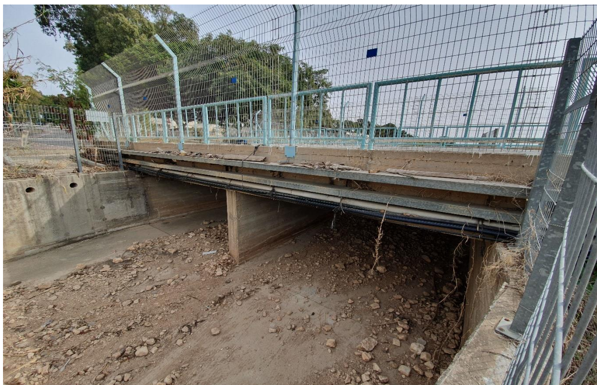
איור 7: עליון - מובל נחל מצר במעלה ובמורד הגשר. תחתון - הגשר ותשתיות צמודות
