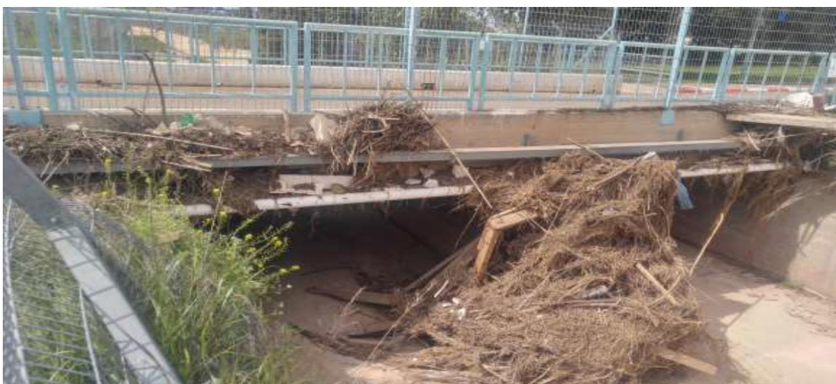
איור 8: גשר שער מנשה נחסם בעקבות הצטברות סחף על עמוד התמך
